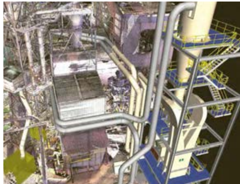
In der folgenden Abbildung ein Beispiel für die Kombination aus einem 3-D-CAD-Modell und einem 3-D-Scan zur Veranschaulichung, wie neues Design innerhalb einer komplexen bestehenden Anlage gestaltet werden kann.
