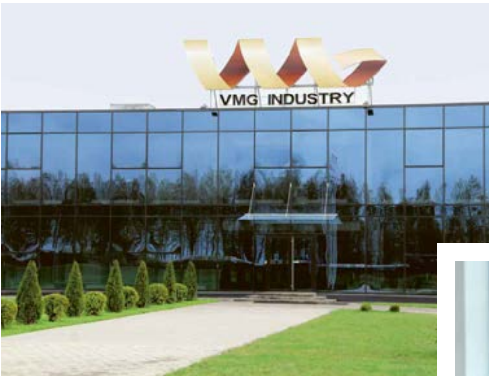
Verwaltungsgebäude VMG Industry in Mogilev, Weißrussland
