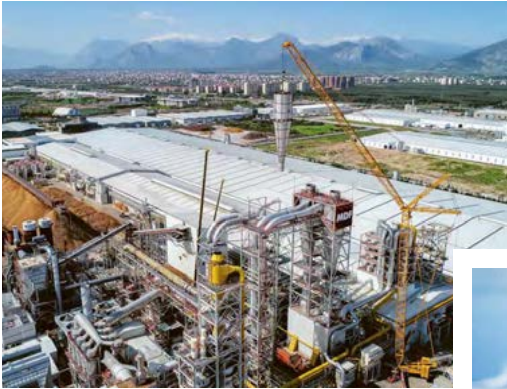
AGT-Produktionsstandort in Antalya: passgenaue Montage eines neuen Trockner-Zyklons, geliefert von der Siempelkamp-Tochter Büttner
